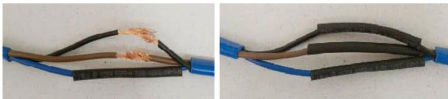
**Passo 3.** Aperte os três cabos com fita isolante.
