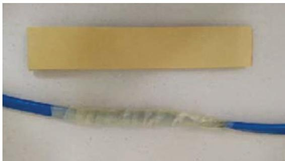
**Passo 4.** Cubra o cabo com um grande tubo retrátil.
