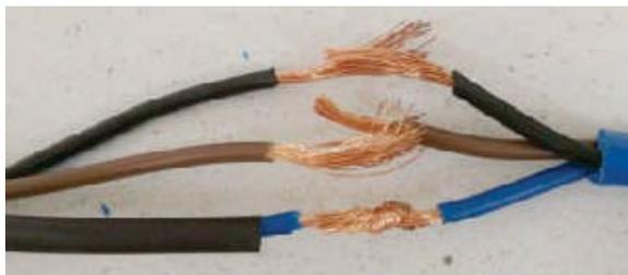
**Passo 2.** Cubra a junta com um pequeno tubo retrátil.
