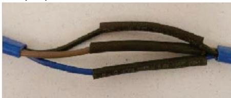
**Passo 3.** Aperte os três cabos com fita isolante.
