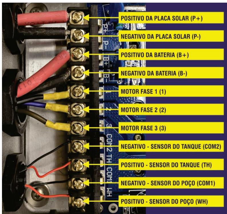
Se a instalação foi realizada corretamente, assim que conectar as placas nos terminais positivo e negativo do controlador, o sistema se inicializa e em um minuto a bomba começa a trabalhar.
